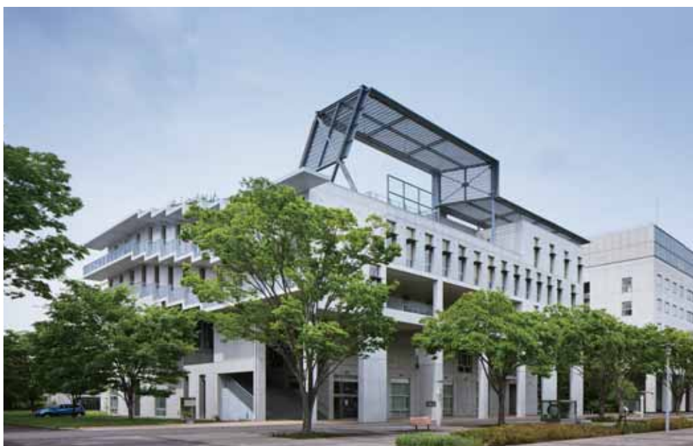
カブリ数物連携宇宙研究機構 (Kavli IPMU) 棟の外観(下)と1階廊下にある約16メートルの大黒板(上)。大黒板は研究者の日頃の議論に活用されている。
